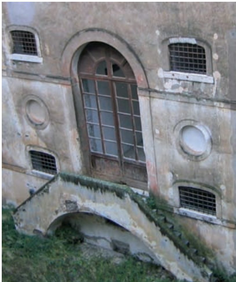
Fig. 4 - L'ingresso all'ex capella del carcere, prima del restauro (2004).
